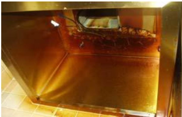
天蓋に油脂が付着した状態
