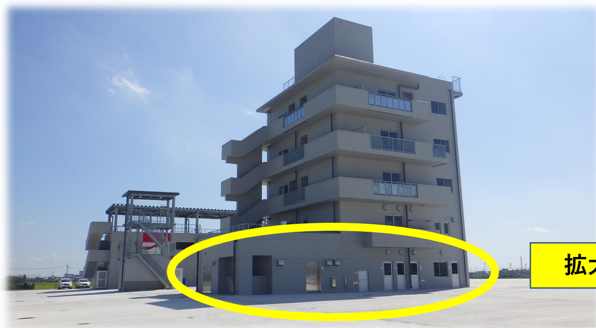
訓練塔A塔
