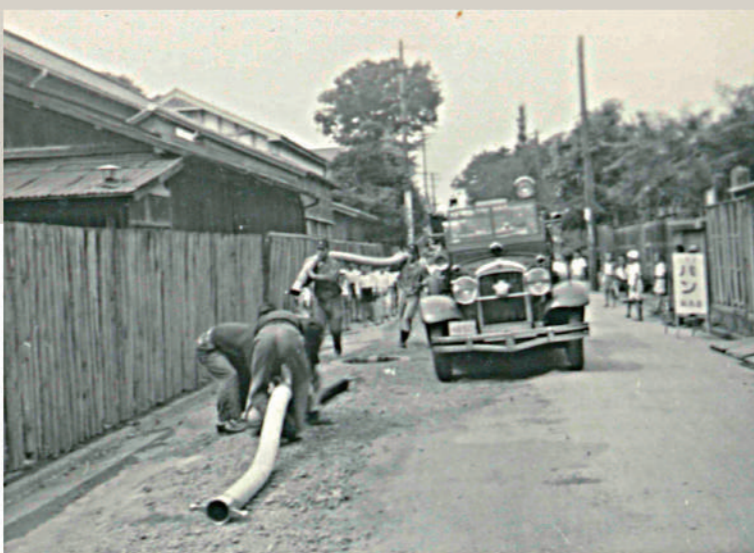
現場到着したハドソン号。ただちに吸水管の接続作業にあたる消防隊員たち
