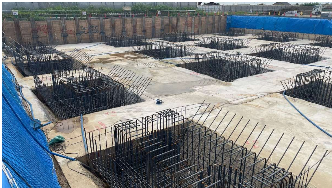
ベース配筋工事の状況 [2024.8月上旬]
