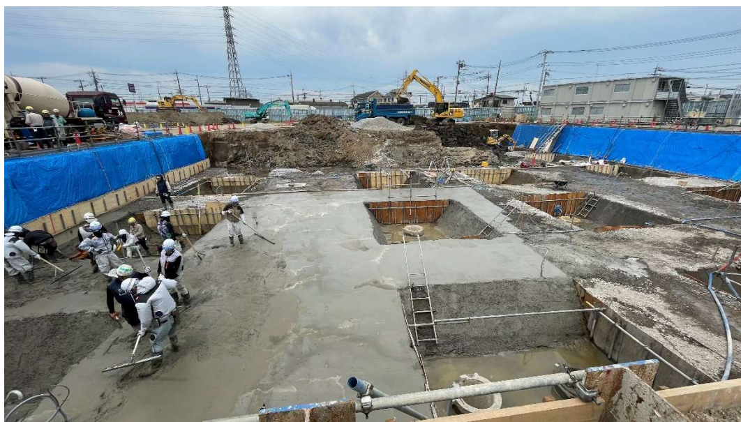
捨てコン打設の状況 [2024.7月上旬]
