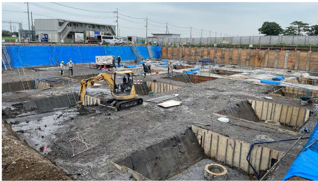
掘削工事の進捗状況 [2024.7月中旬]
