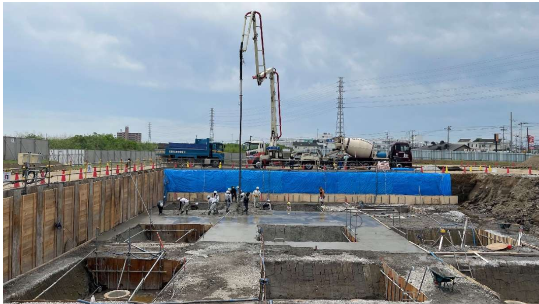
捨てコン打設の状況 [2024.7月上旬]
