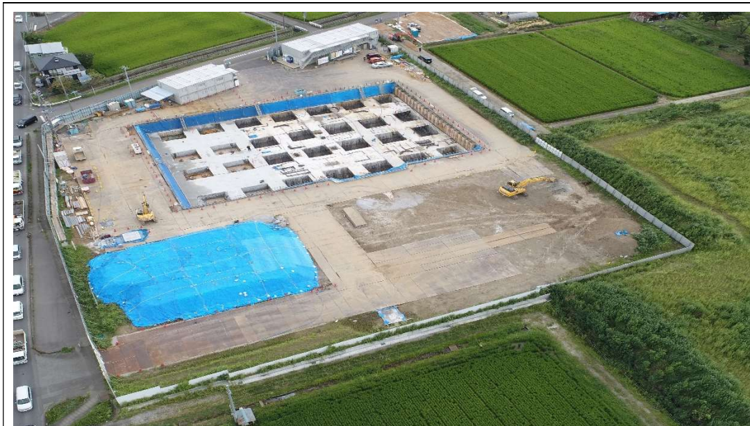
ベース配筋工事の状況 [2024.7月下旬] ※敷地南西側上空から撮影
