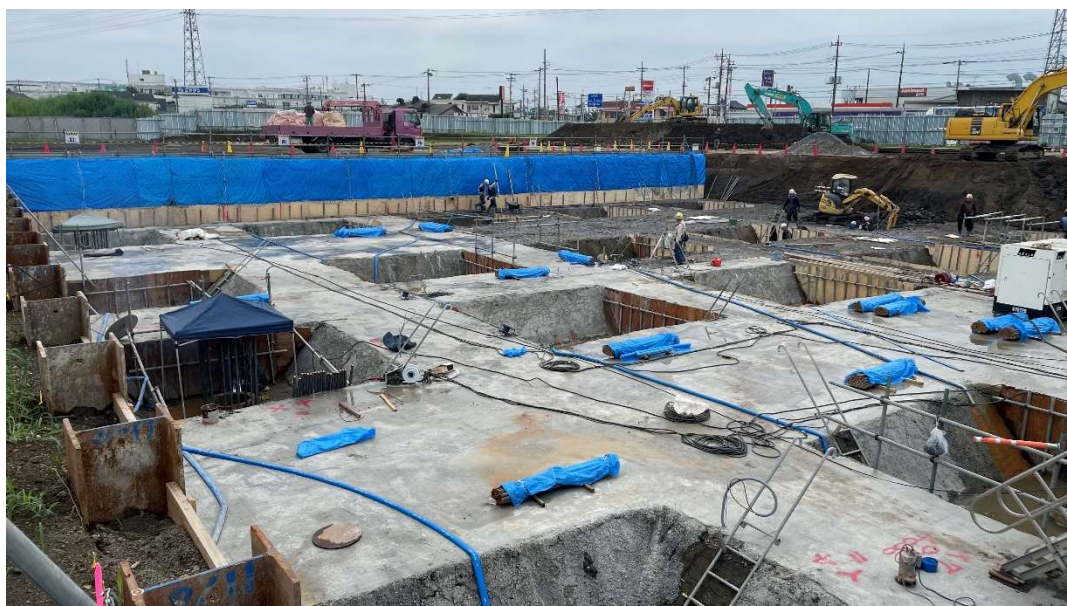
掘削工事の進捗状況 [2024.7月中旬]
