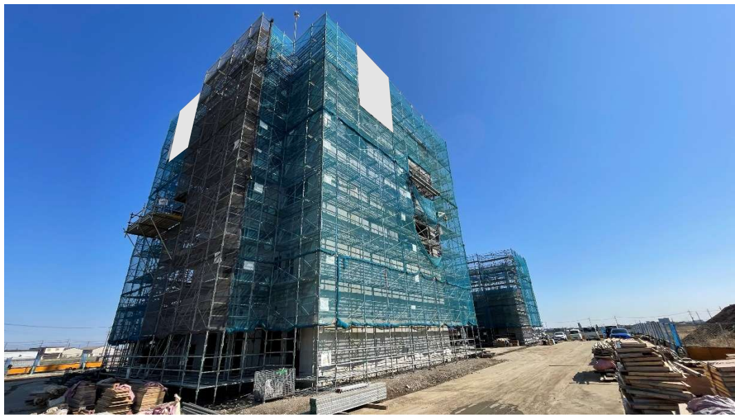
A塔躯体工事状況 [2026.3月中旬]
