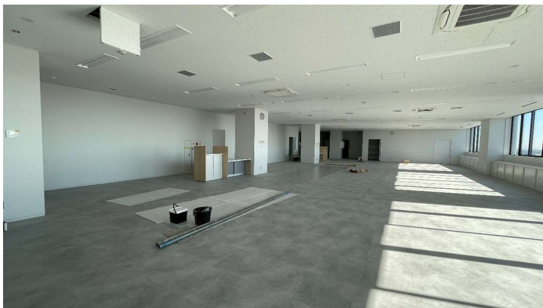
3 階内装工事状況 [2025.11 月上旬]
