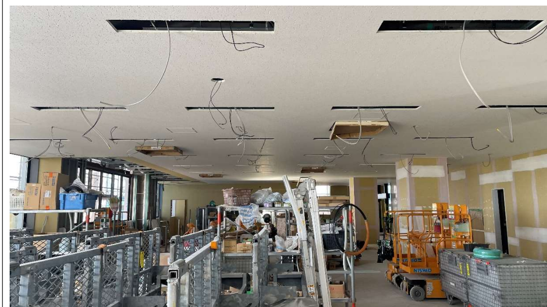
3階内装工事状況 [2025.9月上旬]
