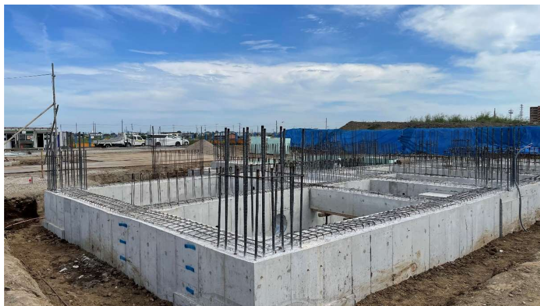
基礎工事状況 [2025.9月下旬]
