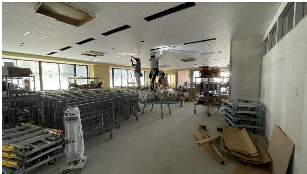
1 階内装工事状況 [2025.7月下旬]
