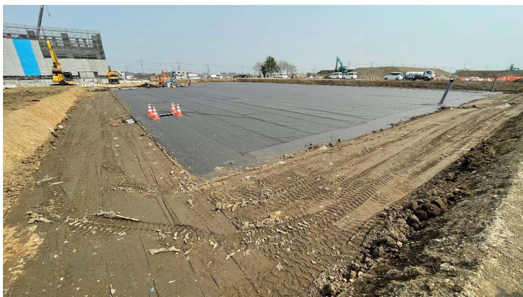
本体埋戻施工状況 [2025.3 月下旬]
