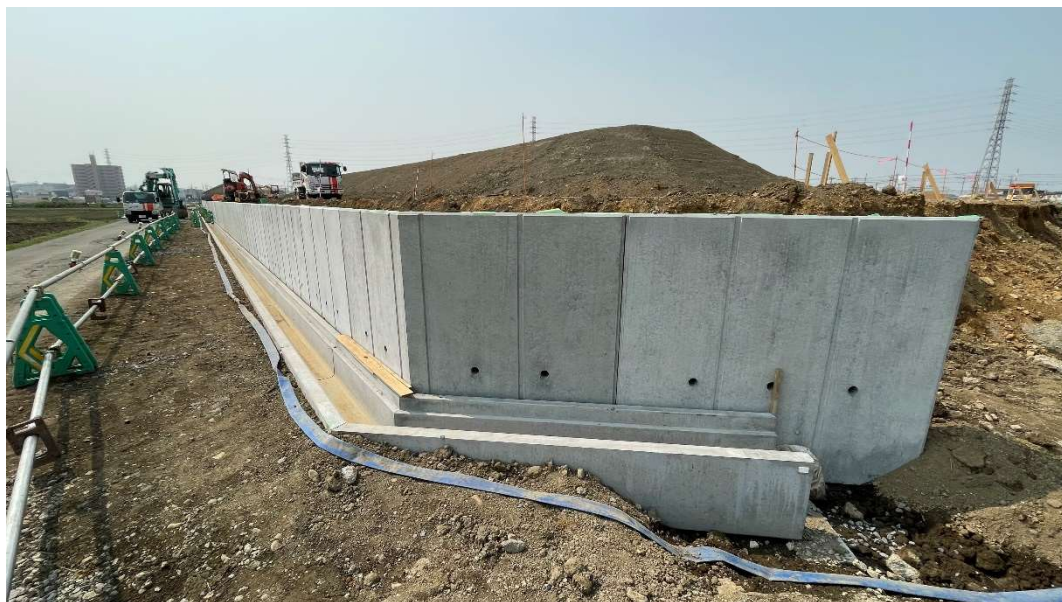
敷地東側外周道路の擁壁施工状況 [2025.3 月下旬]
