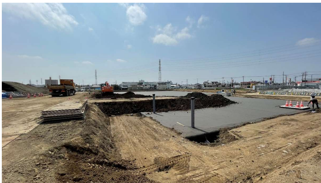
本体埋戻施工状況 [2025.3 月下旬]
