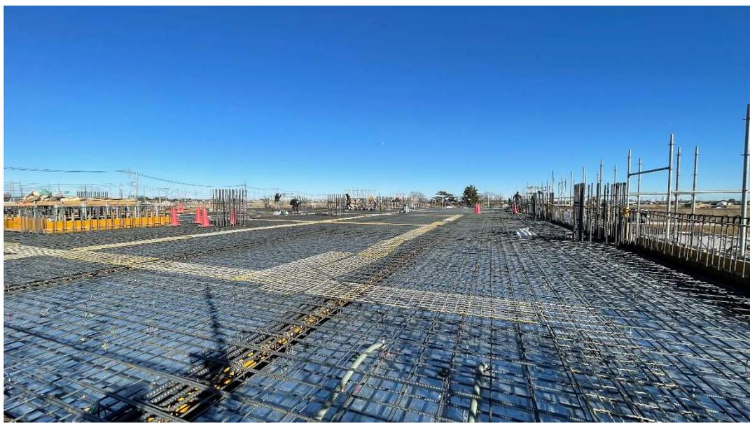
2階床梁配筋工事の施工状況 [2025.1月上旬]
