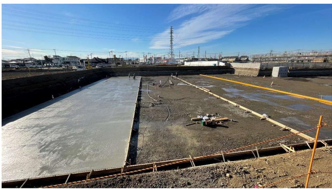
底盤生コン打設の施工状況 [2025.1 月中旬]
