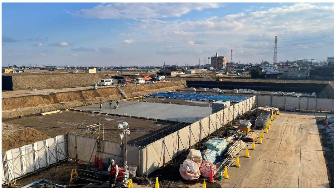
底盤生コン打設の施工状況 [2025.1 月下旬]
