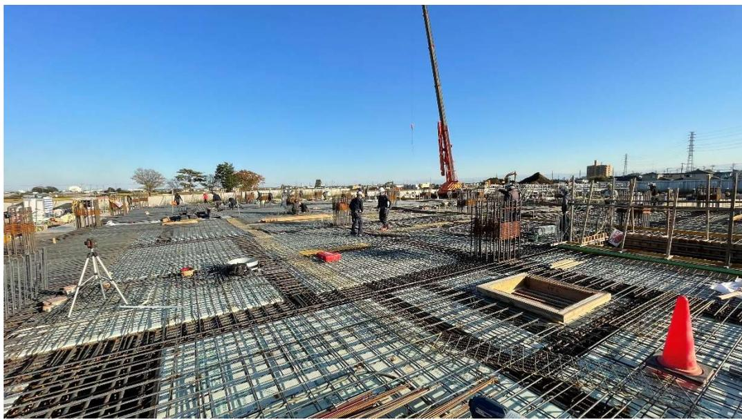
1階床配筋工事の施工状況 [2024.1 1月中旬]
