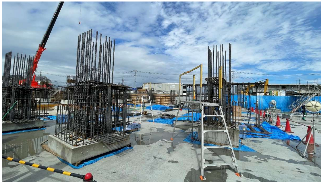
免震装置上部躯体の施工状況 [2024.10月中旬]
