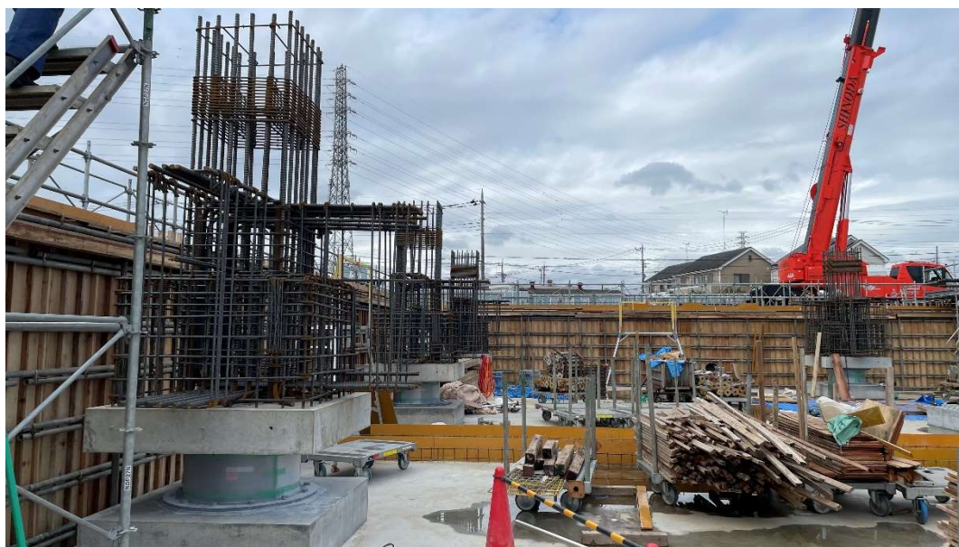
免震装置上部躯体の設置状況 [2024.10月中旬]
