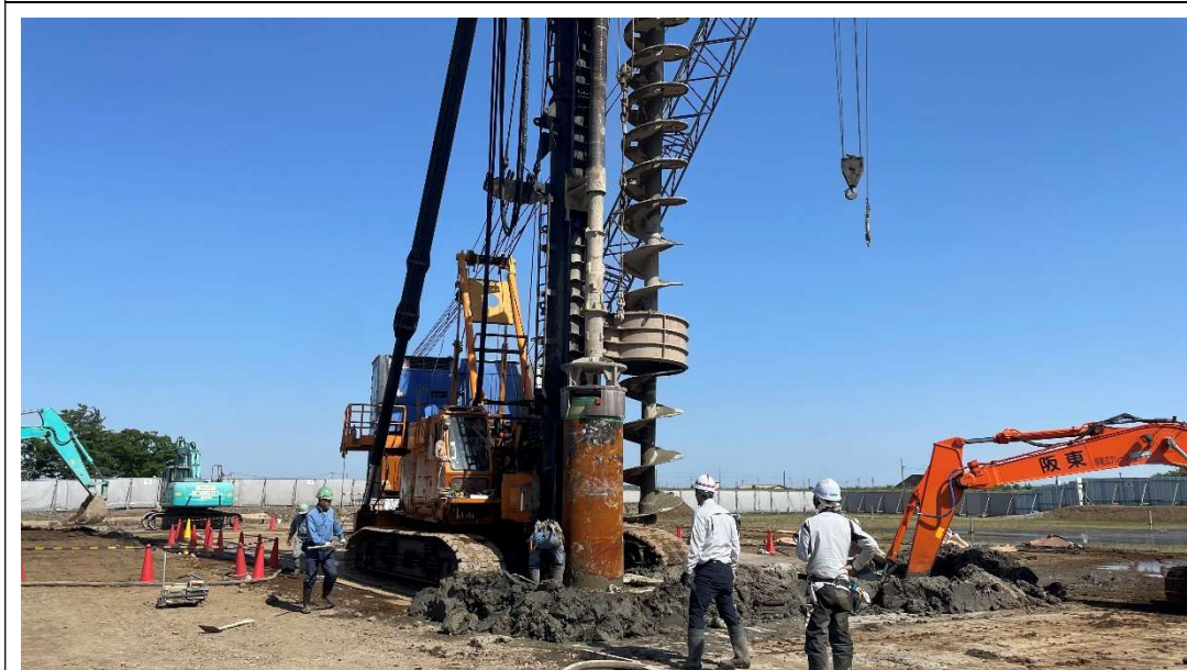
杭打設工事 [2024.5月上旬]
