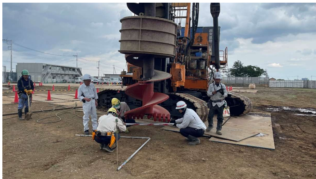
杭打設工事 [2024.5月上旬]
