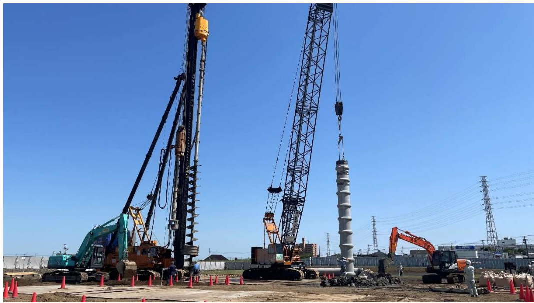
杭打設工事 [2024.5月上旬]
