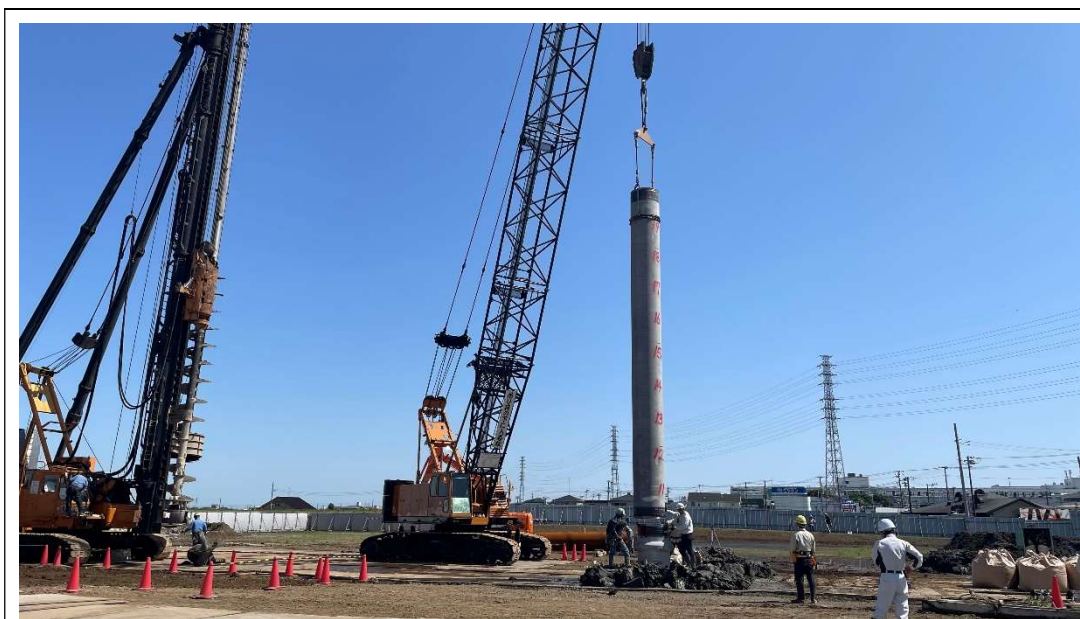
杭打設工事 [2024.5月上旬]
