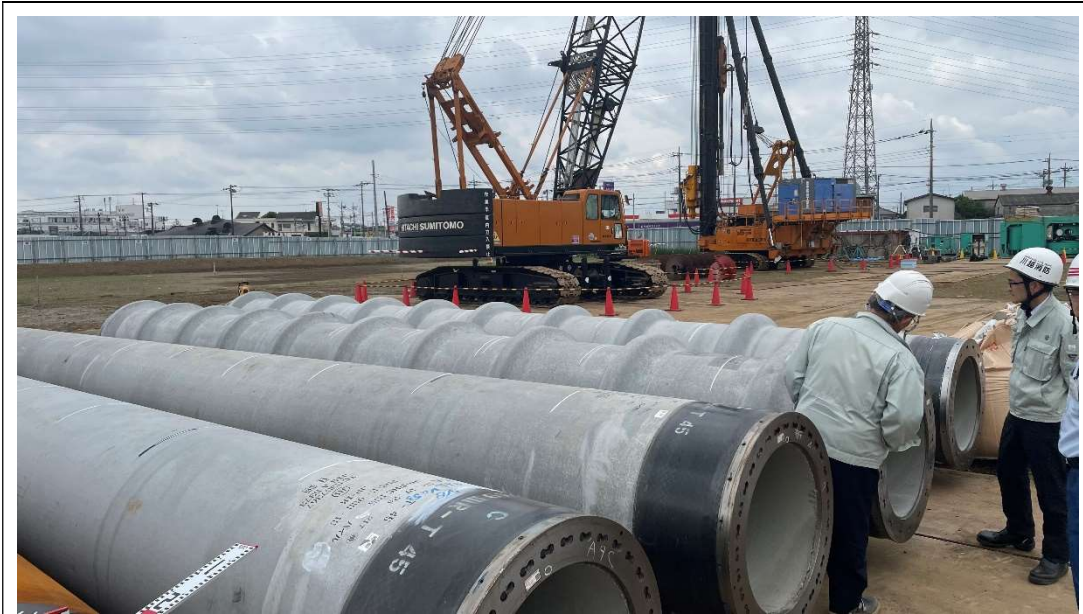
杭打設工事 [2024.5月上旬]
