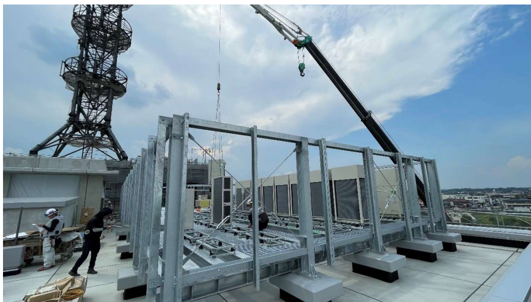
屋上設備工事状況 [2025.8 月下旬]
