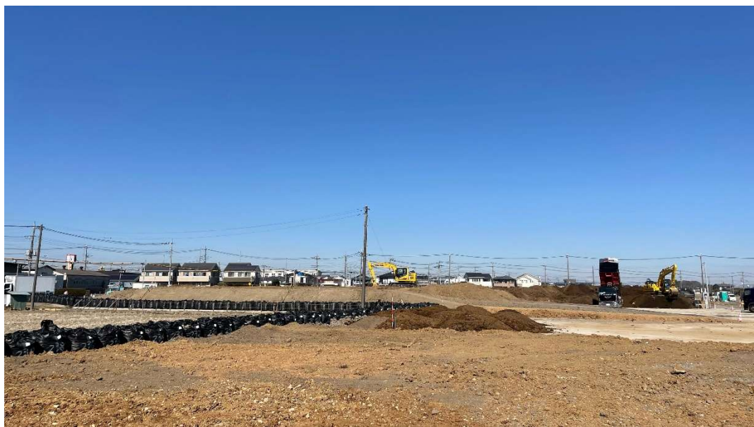
盛土工 [2023.2 月下旬] ※敷地南側から撮影
