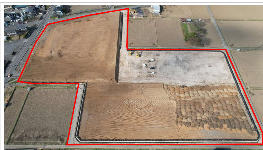
第1期盛土工完了〔2023.3月下旬〕 ※敷地南側上空から撮影
