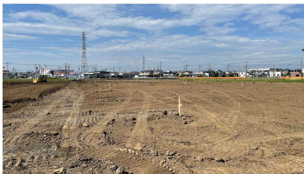
整地作業完了 [2022.10月上旬 撮影] ※敷地南東側から撮影
