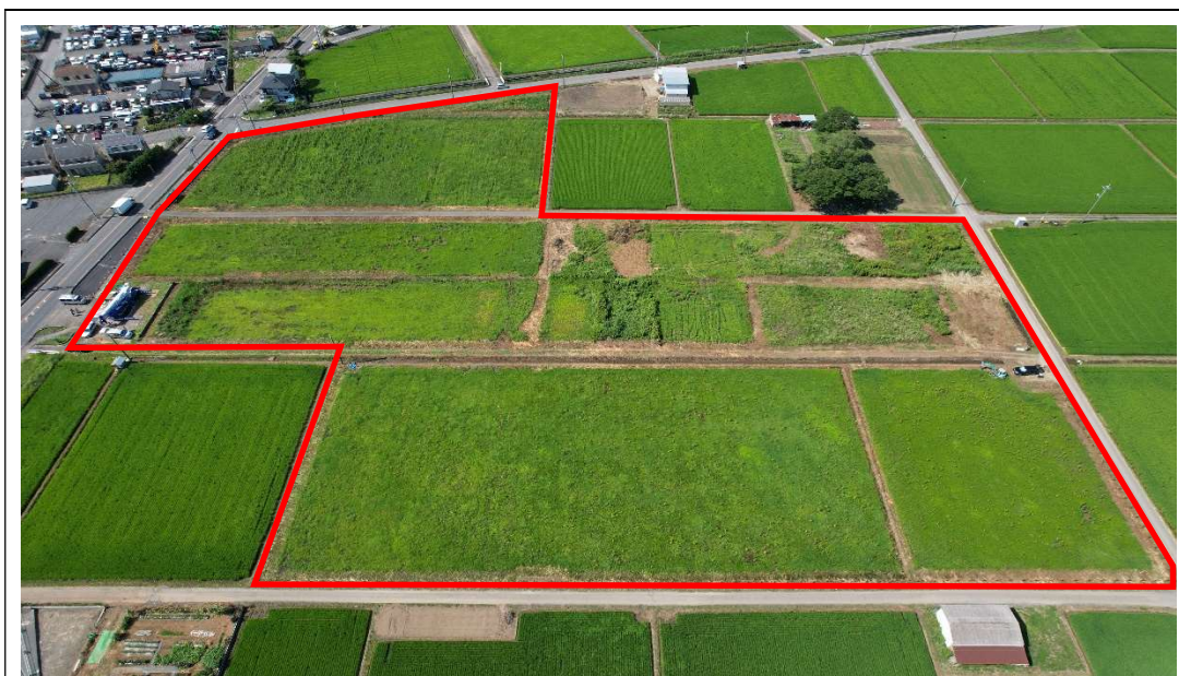
造成工事着手前 [2022.7月下旬 撮影] ※敷地南側上空から撮影
