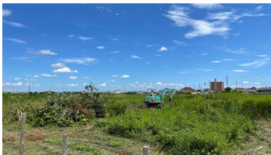
整地作業着手 [2022.7月下旬 撮影] ※敷地北側から撮影
