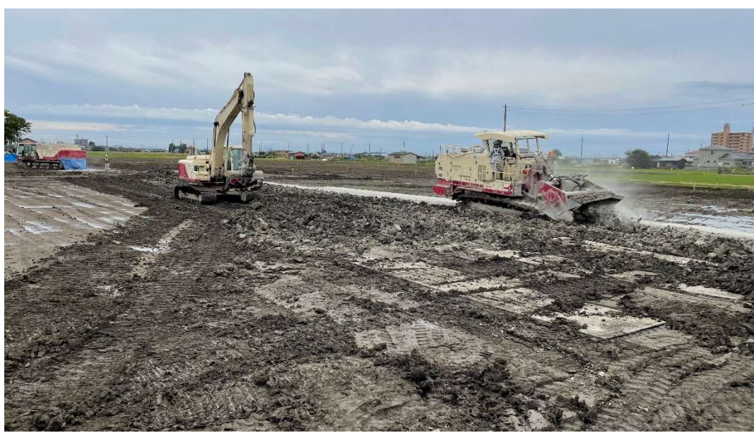
路床安定処理工 [2022.10月下旬 撮影] ※敷地西側から撮影
