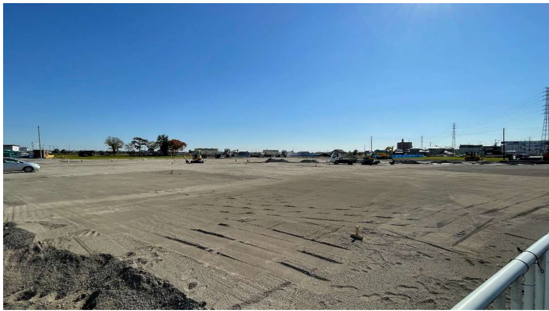
路床安定処理工後サンドマット敷設 [2022.11月上旬 撮影] ※敷地北西側から撮影
