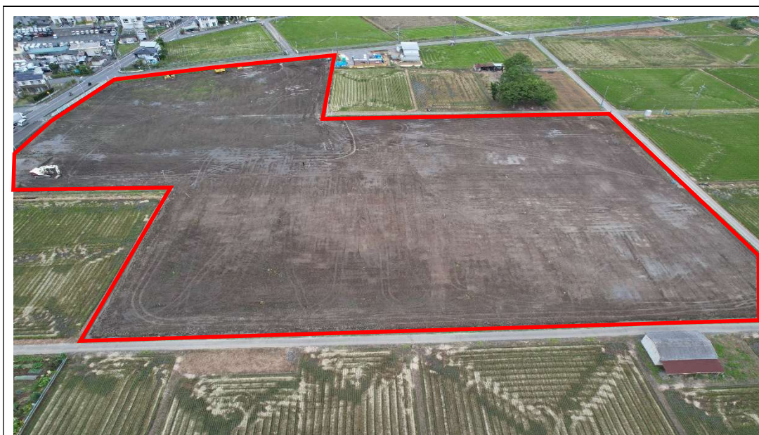
整地作業完了 [2022.10月上旬 撮影] ※敷地南側上空から撮影
