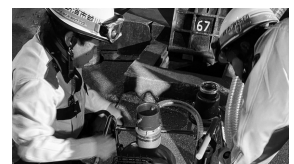
排水ポンプの組み立て
