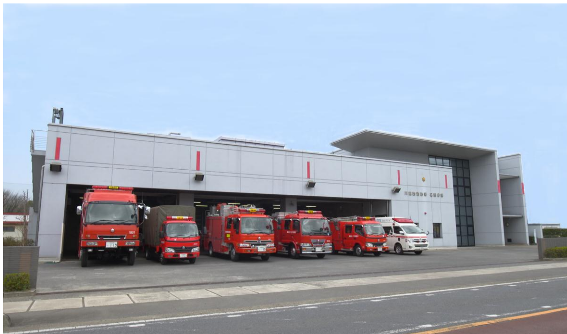
◆川越西消防署名細分署 平成16年3月31日竣工
