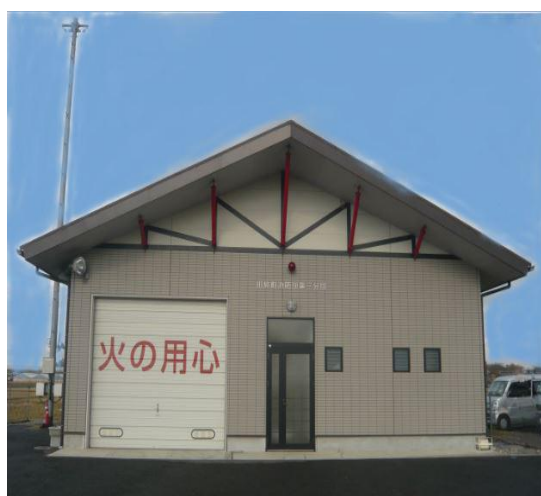
◆川島町消防団第三分団車庫 平成19年3月15日竣工
