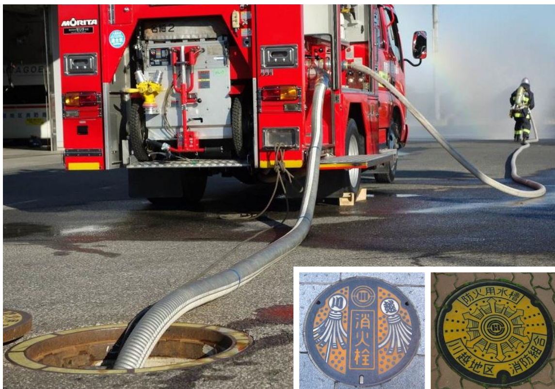
◆ 防火水槽から吸水する消防ポンプ車
