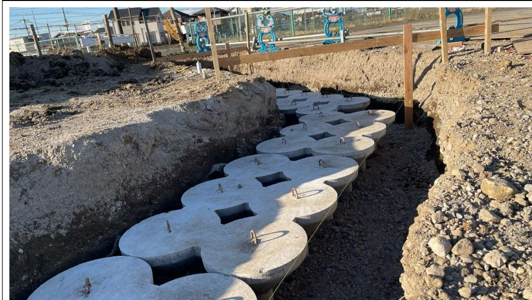
第1期擁壁工 [2023.1 2月下旬] ※敷地北側外周部
