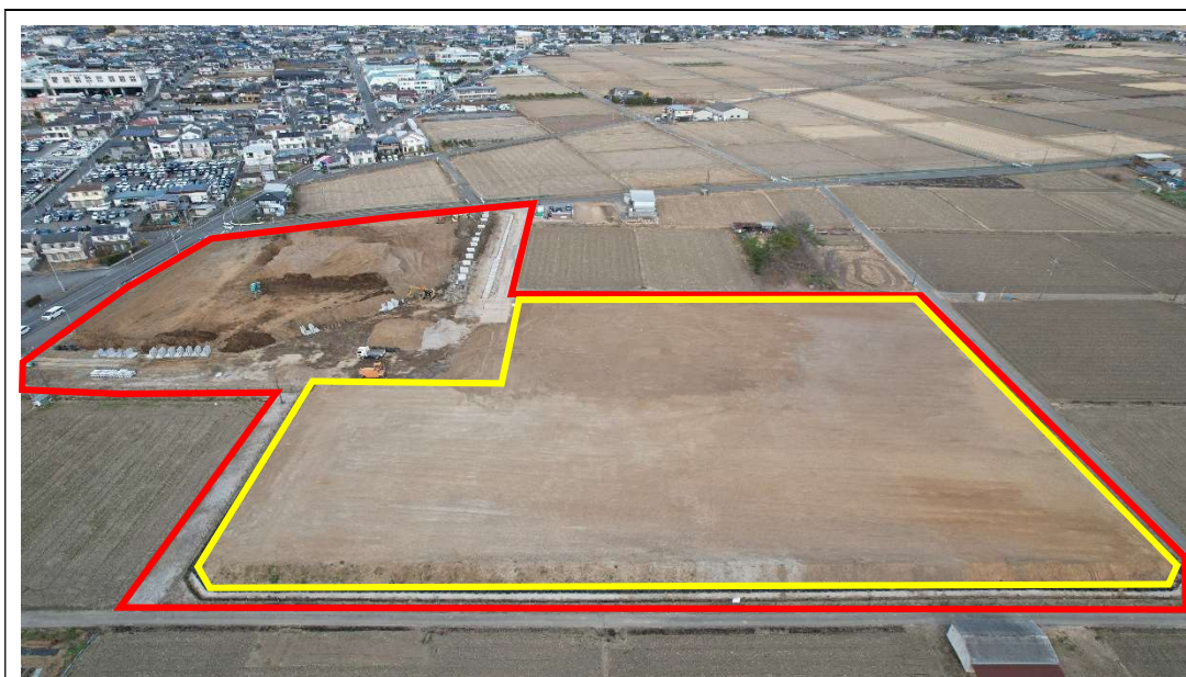
第1期擁壁工 [2023.1 2月下旬] ※敷地南側上空から撮影
