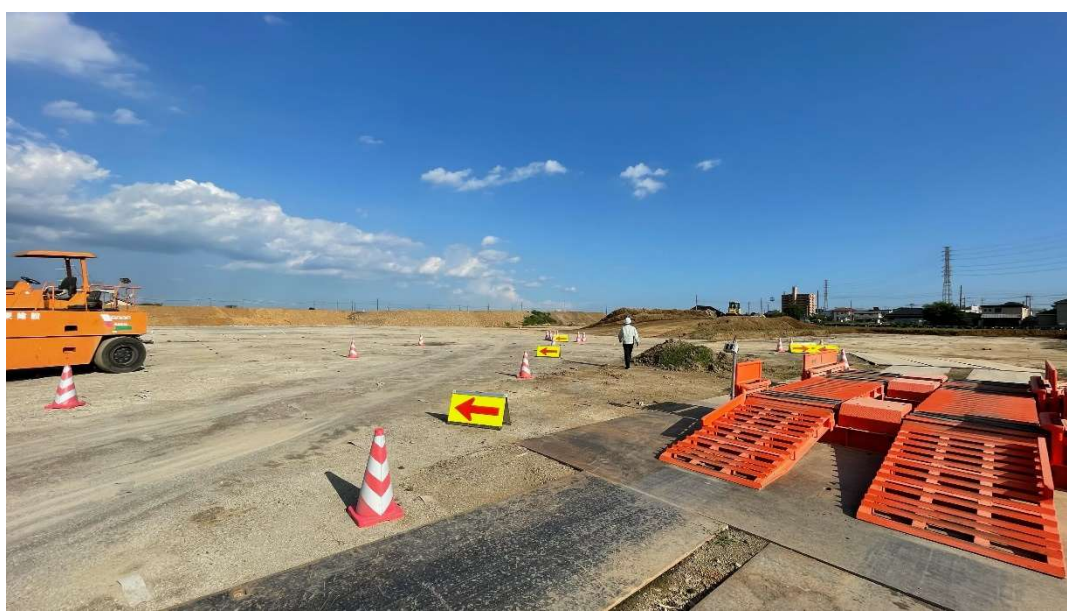
第2期盛土工 [2023.8月中旬] ※敷地中央部から南東側を撮影
