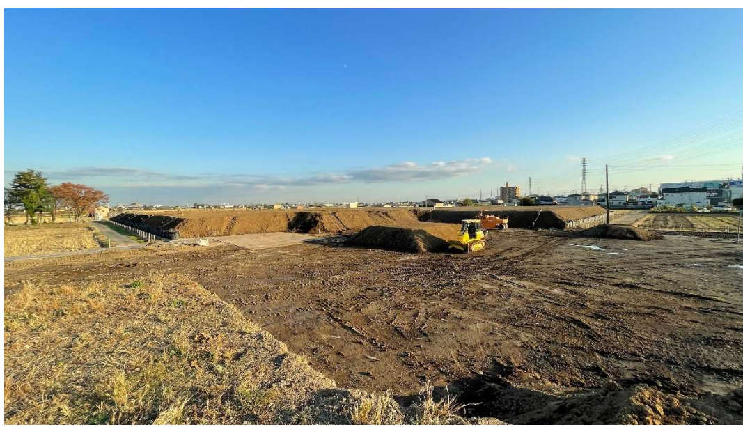
第2期盛土工 [2023.1 1月下旬] ※敷地中央付近から南東側を撮影
