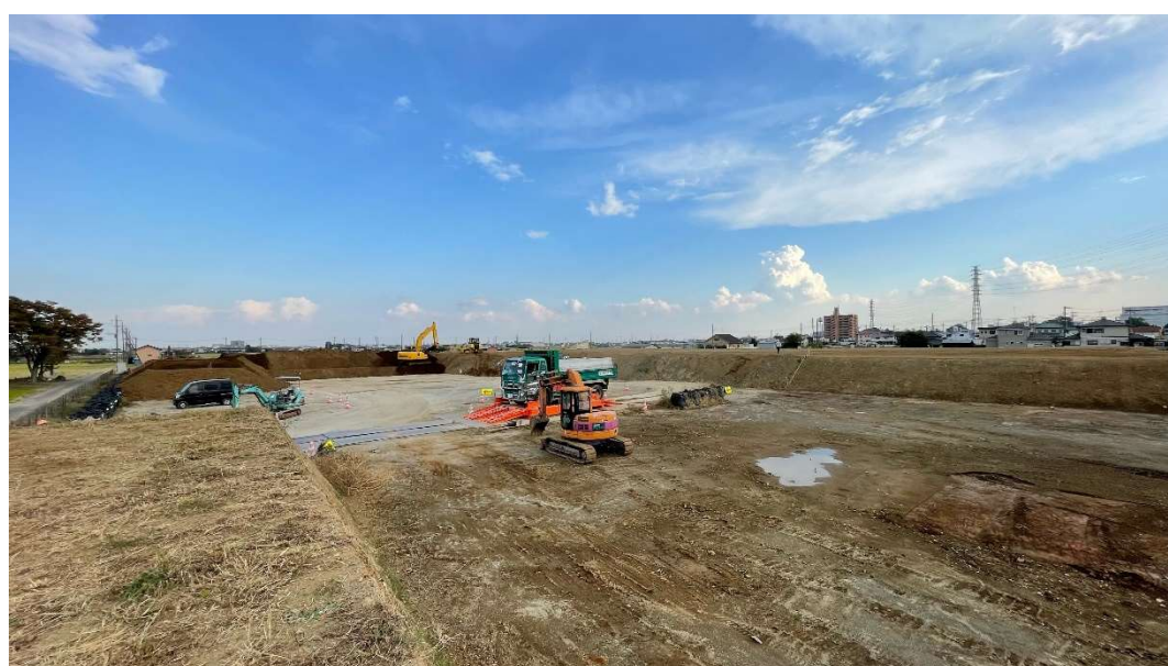
第2期盛土工 [2023.10月下旬] ※敷地中央付近から南東側を撮影
