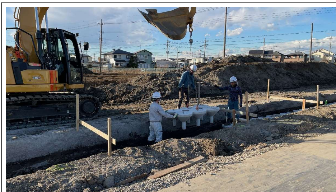
第1期擁壁工 [2023.1 2月下旬] ※敷地北側外周部
