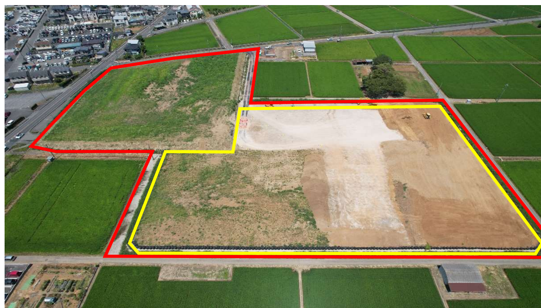
第2期盛土工 [2023.7月下旬] ※敷地南側上空から撮影
