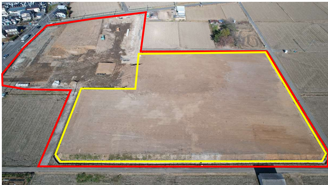
第2期盛土工 [2023.1 2月中旬] ※敷地南側上空から撮影
