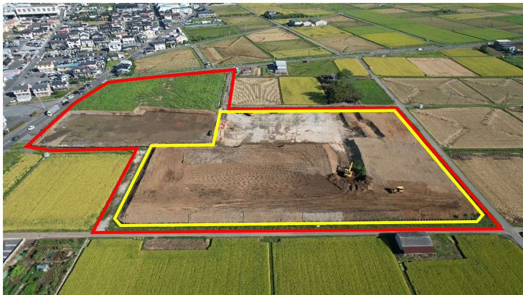
第2期盛土工 [2023.9月中旬] ※敷地南側上空から撮影
