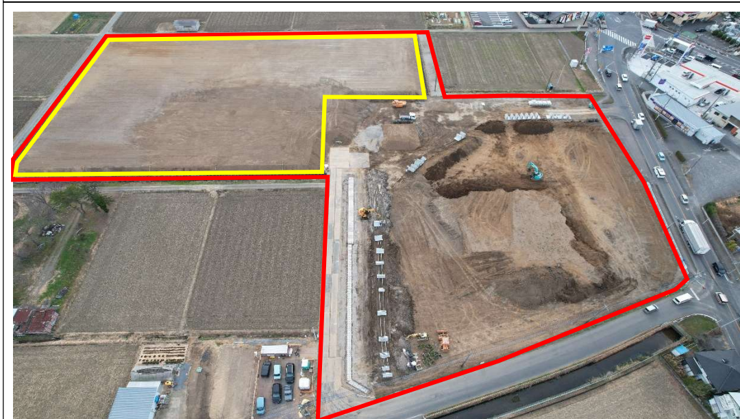
第1期擁壁工 [2023.1 2月下旬] ※敷地北側上空から撮影
