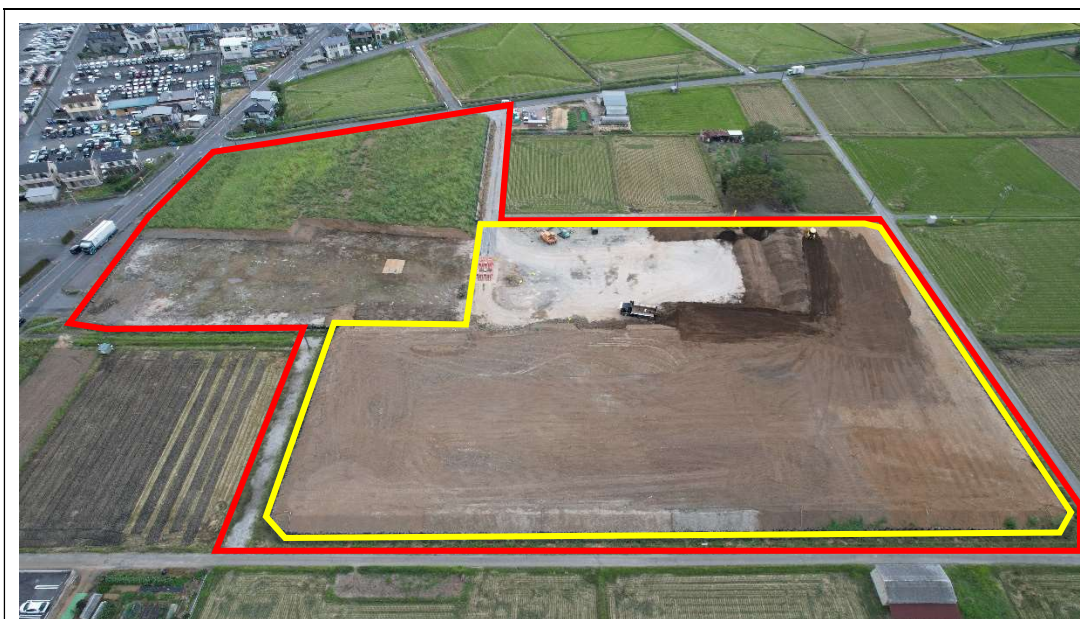
第2期盛土工 [2023.9月下旬] ※敷地南側上空から撮影
